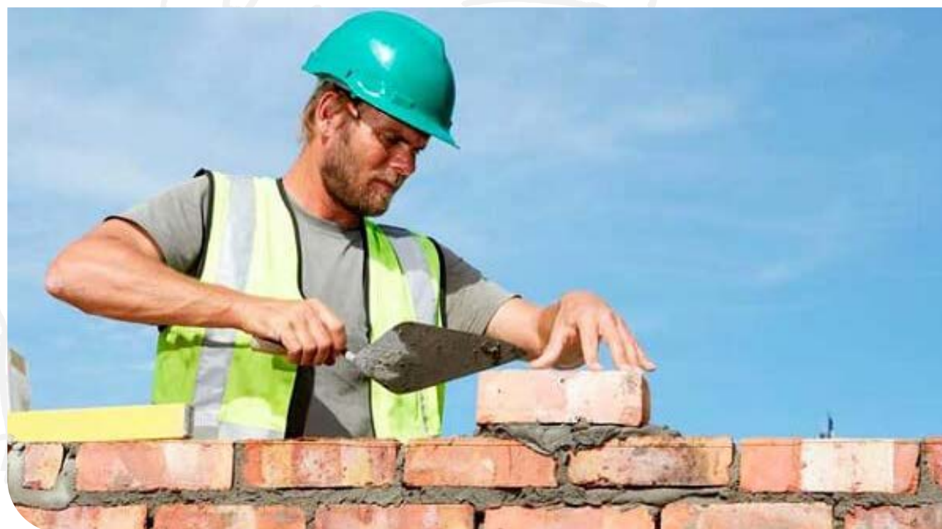
Figura 2. Imágen referencia. Albañil construyendo pared
